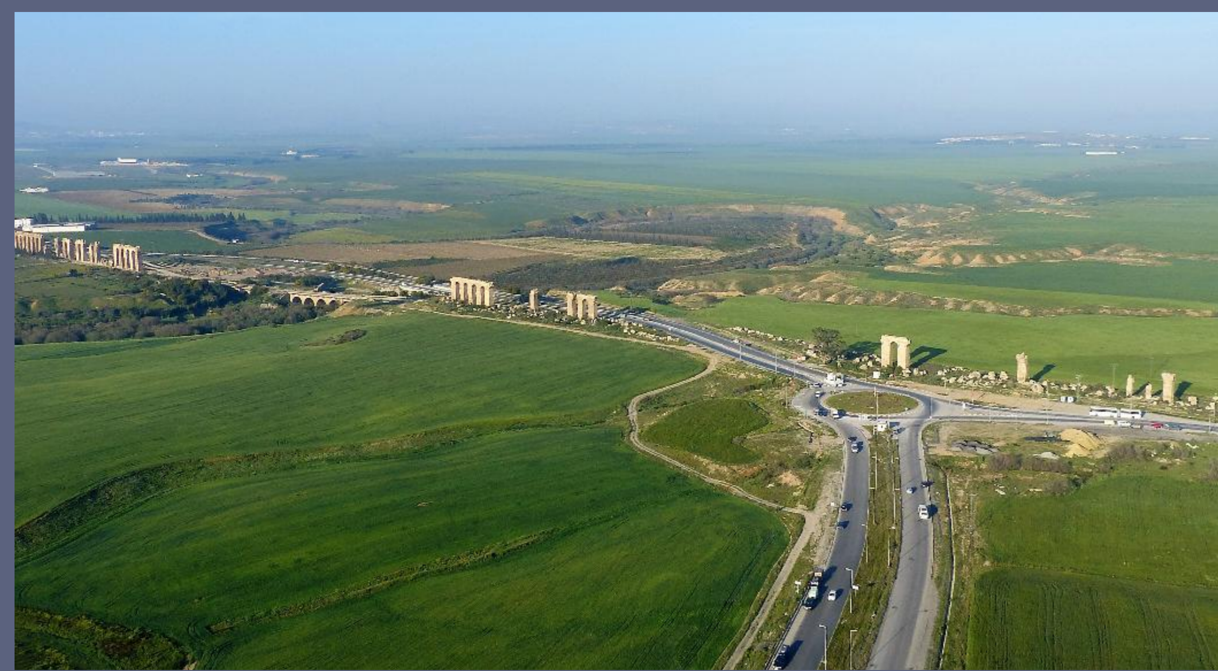
Ci-dessus : L'aqueduc romain de Zaghouan à Carthage traversé par une autoroute (Photographie : Wiki Commons).
